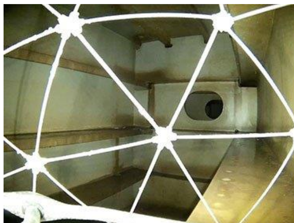
Przegląd ogólny zbiornika balastowego na statku. ( https://www.flyability.com/other-industries )
