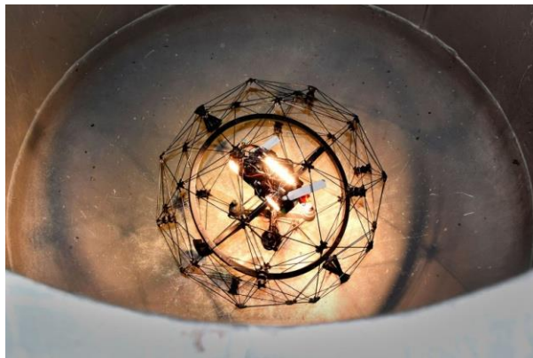
ELIOS podczas przeglądu zbiornika ciśnieniowego ( www.flyability.com/hubfs/Flyability_chevron_pressure_08-1600x1062.jpg )
